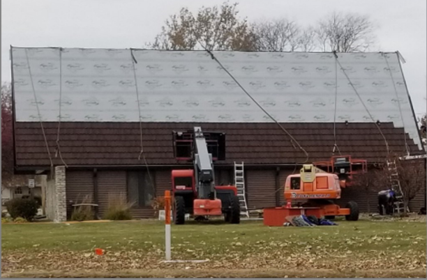
Apply Moisture Barrier Membrane
